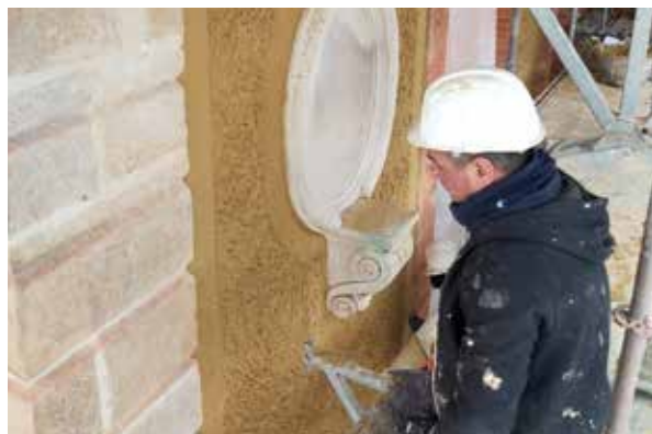
Réfection des enduits traditionnels Domaine de Dampierre (78) - Ets Pierre Noël
