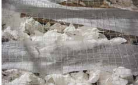
Pose du treillis sur pans de bois
