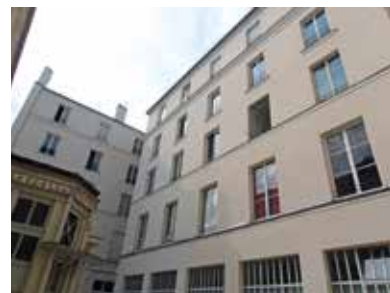
Chantier terminé - Façade rénovée en PARIS DÉCO®
