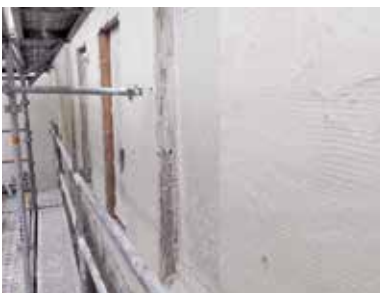
Vue de la couche de 8 cm une fois terminée
